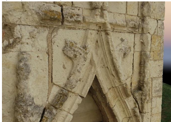
Restitution photogrammétrique en 3D MESCH Après prise de vue par drone
